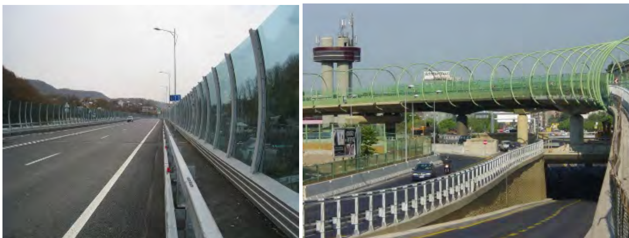
Рис. 10. Виды акустических шумозащитных экранов на магистрали: а — федерального; б — регионального значений
