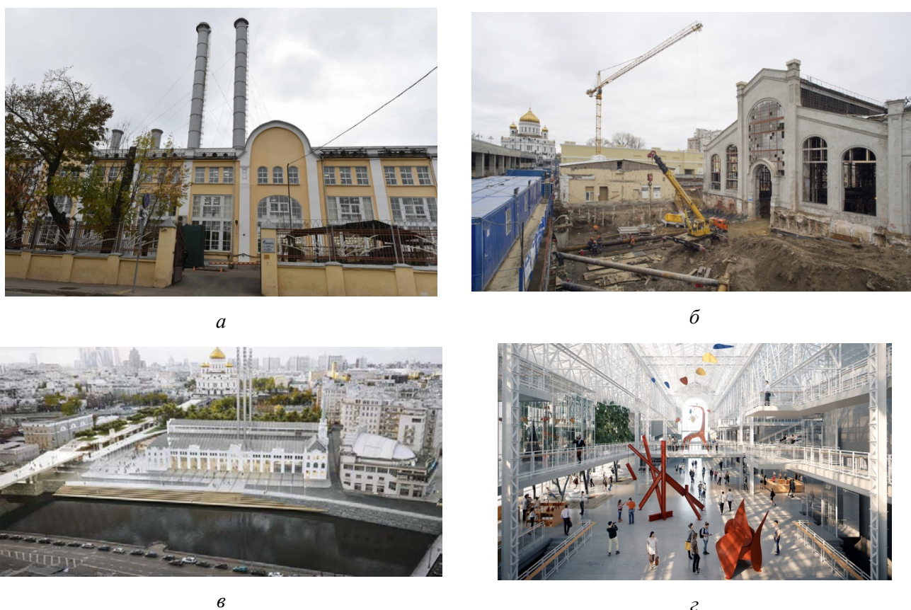
Рис. 13. Реконструкция здания бывшей ГЭС-2 на Болотной набережной (г. Москва):
