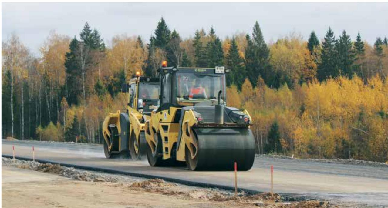
Укладка асфальтобетона с применением гранулированного шлака
