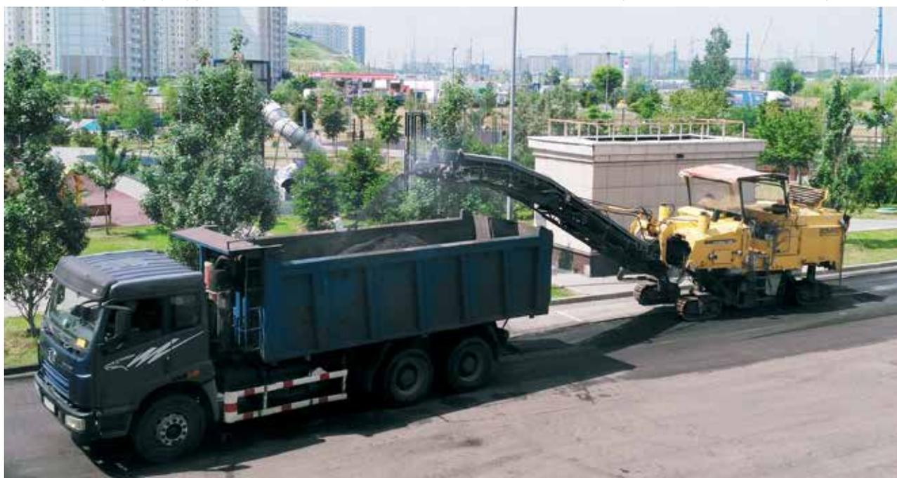
Снятие верхнего слоя с помощью дорожной фрезы
