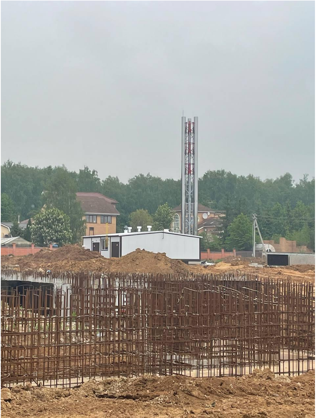
Рисунок 43. Корпус 13. Устройство армирования вертикальных конструкций
