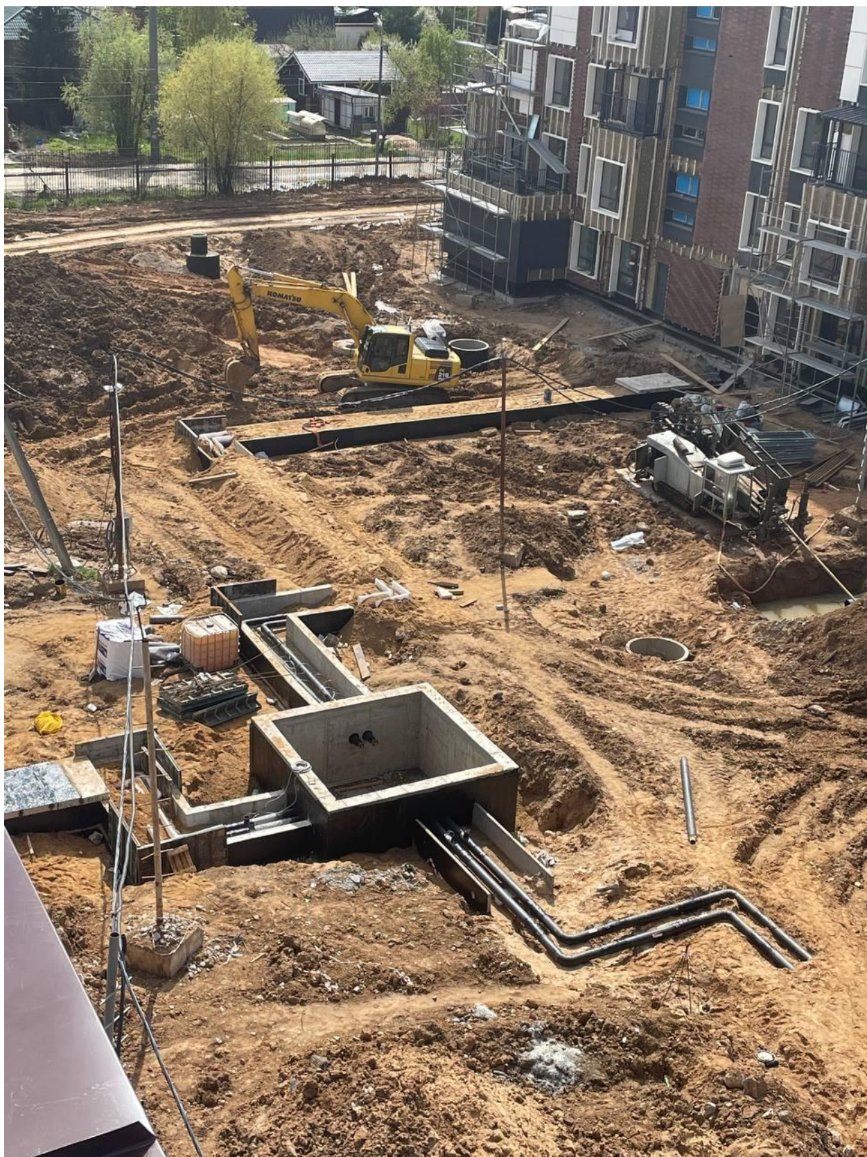
Рисунок 42. Корпус 13. Прокладка наружных инженерных сетей
