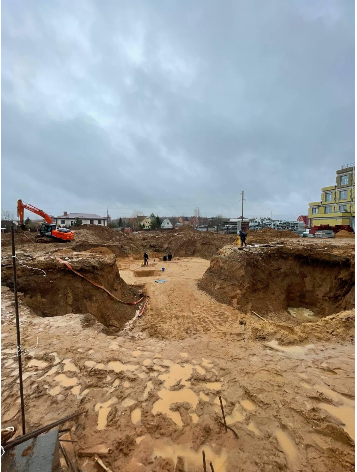
Рисунок 41. Корпус 13. Подготовка основания фундамента.
