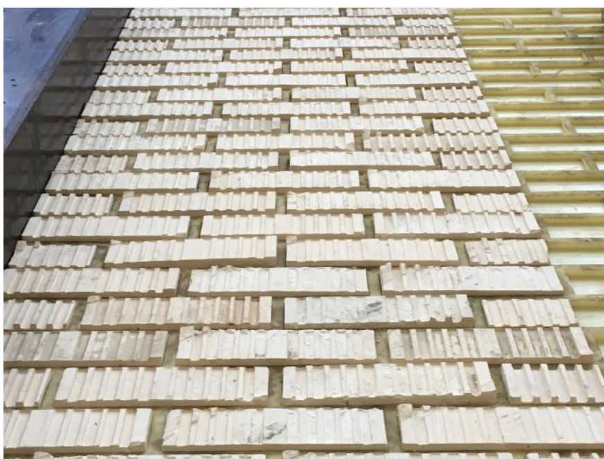
Рис. 2. Укладка керамической плитки на полиуретановую матрицу
