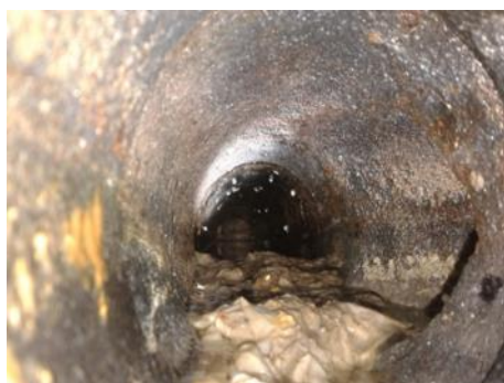
Рис. 1. Внешний вид отложений в канализационных сетях
