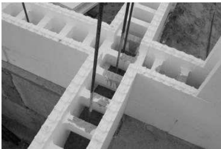
Рис. 1. Технология строительства с постоянной опалубкой
