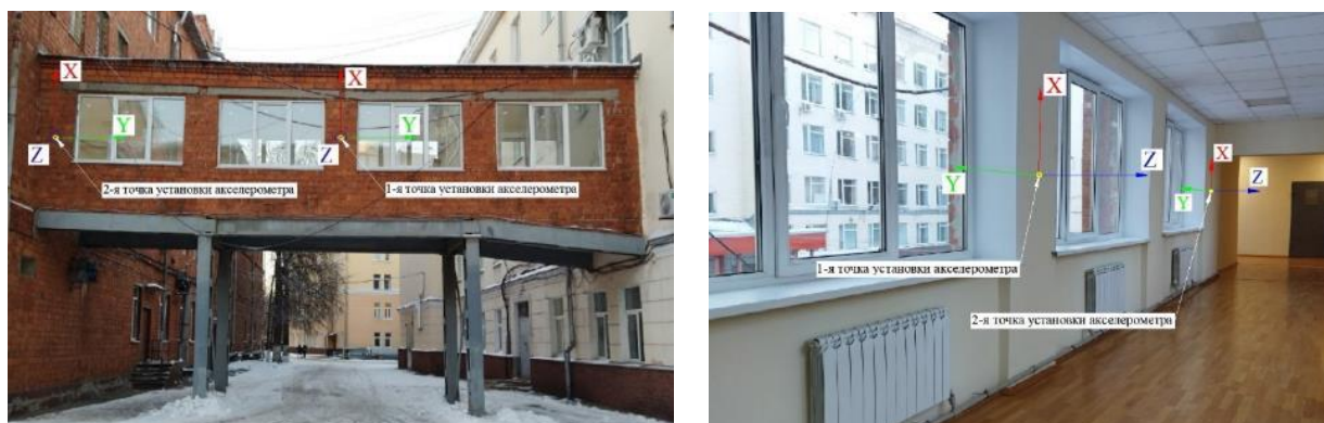
Рис. 2 – Общий вид перехода снаружи и внутри здания.
