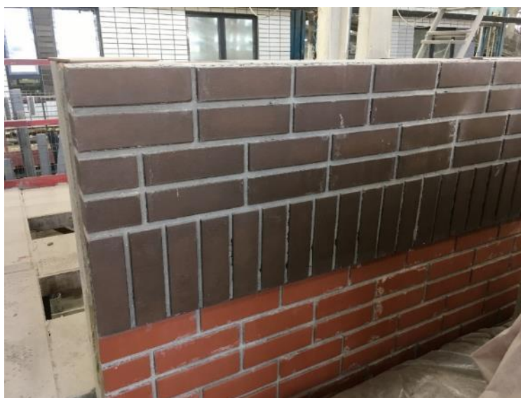
Рис. 3. Наружная железобетонная стеновая панель с керамической плиткой
