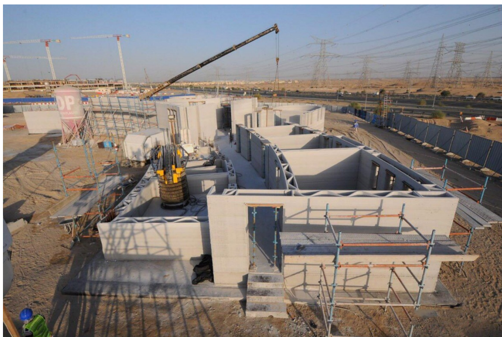
Рис. 2. Процесс строительства муниципалитета в Дубае с использованием 3D печати
