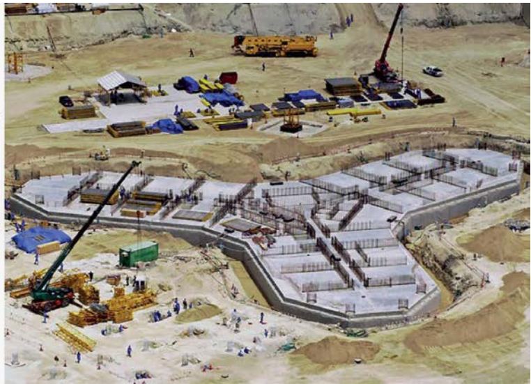
Рис.4. Фундамент на начальном этапе строительства
