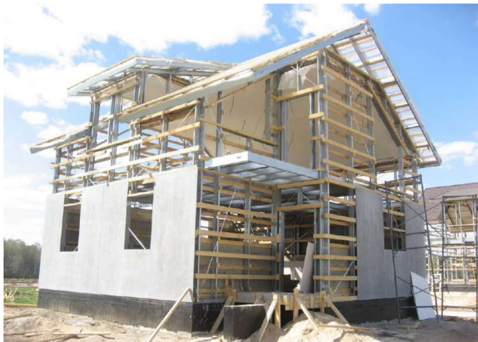
Рис. 1. Строительство каркасно-монолитного дома, с несъемной опалубкой, утепленного пенобетоном
