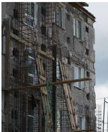
Рис.2 Арматурная конструкция
