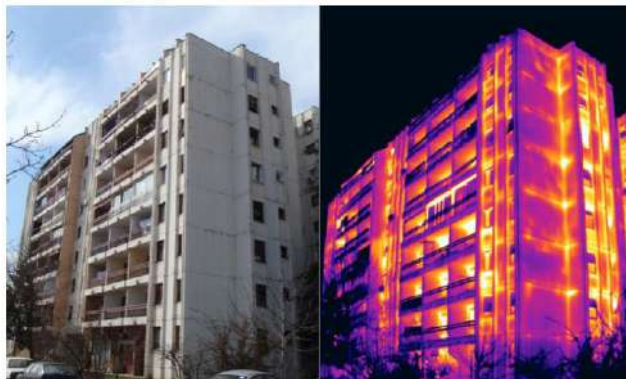
Рис. 2. Инфракрасное изображение панельного здания – Белград
