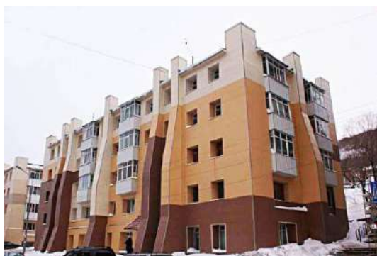
Рис. 3 Завершающий итог после сейсмоукрепления дома
