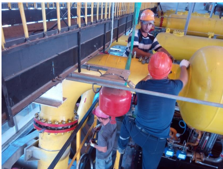
Рис. 1. Замена фильтрующего элемента
