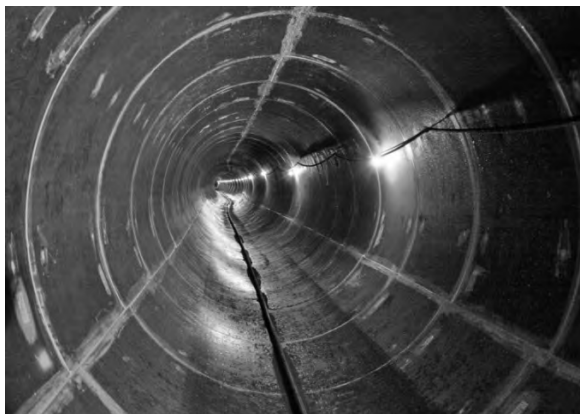
Рис. 3. Подводящий канал к ЛОС после реконструкции
