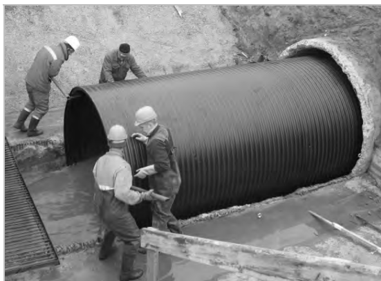
Рис. 4. Реконструкция канализационного коллектора.
