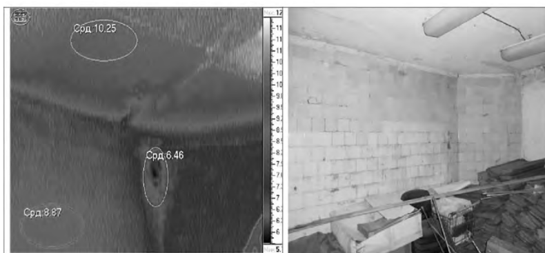
Рис. 2. Съёмка внутри здания (подвал)
