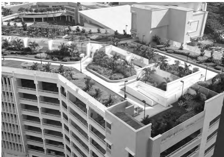
Рис. 1. Обустройство здания с применением технологии «зеленая кровля»
