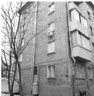
Рис. 2. Дом под снос по улице Коминтерна, 9
