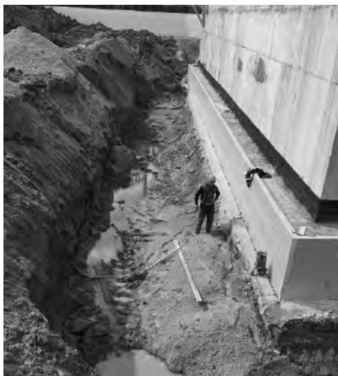
Рис. 2. Котлованы с труднодоступной рабочей зоной
