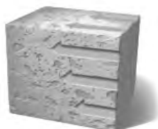
Рис. 3. Бетон после гидроизоляции
