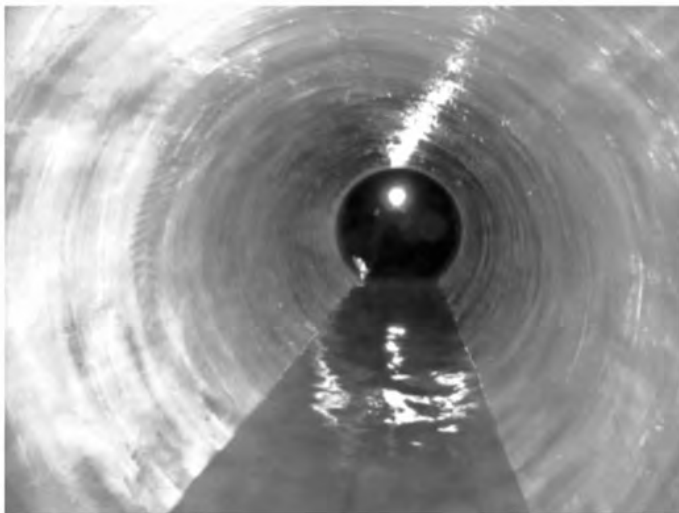
Рис. 4. Восстановленный по комбинированной технологии трубопровод
