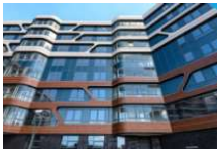
Рис.1. Комбинирование по этажам (Комбинация из витража, кассет и фиброцементных панелей)
