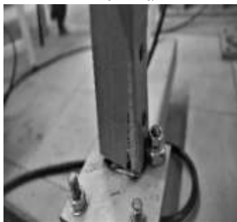
Рис. 3. Характер разрушение образца
