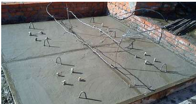
Рис. 2. Метод электродного прогрева
