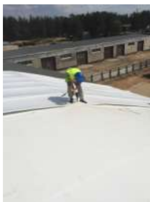
Рис. 2. Монтаж тентового покрытия
