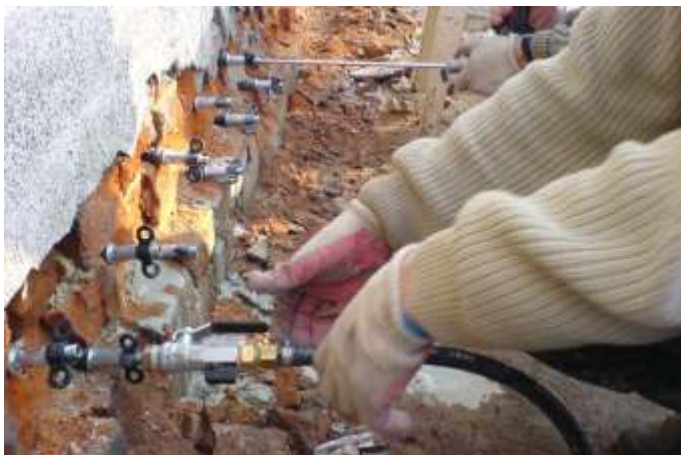
Рис 2. Подключения пакеров к насосу
