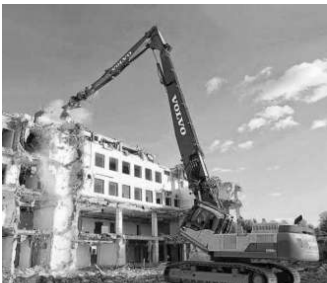
Рис. 1 Демонтаж здания с помощью экскаватора
