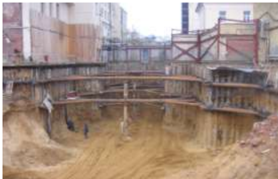
Рис. 1 Строительство объекта в стеснённой застройке - НТСС не требуется
