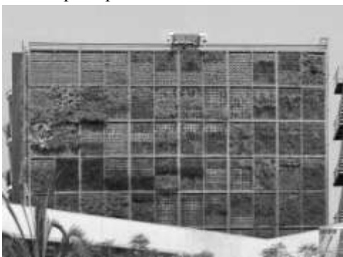
Рис.3 Фасад с модульными контейнерами
