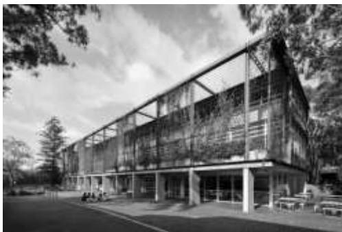
Рис. 1 Вьющийся фасад с применением металлической сетки
