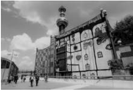
Рис. 3. Мусоросжигательный завод в Вене.
