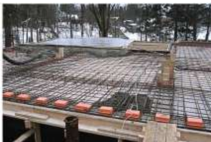
Рис. 3. Теплоизоляция монолитных перекрытий XPS термовкладышами
