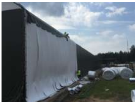
Рис. 2. Монтаж тентового покрытия
