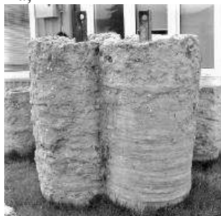
Рис.2 Образовавшиеся грунтоцементные сваи.
