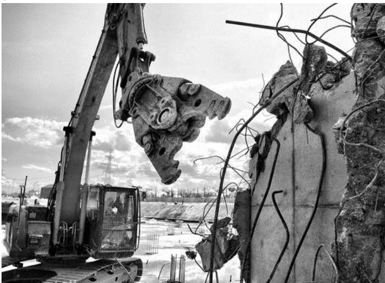
Рис.2 Демонтаж несущей конструкции механическими ножницами
