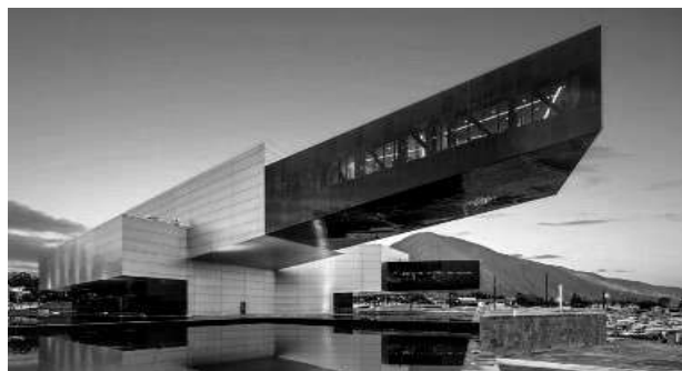
Рис. 5. UNASUR Building, Эквадор
