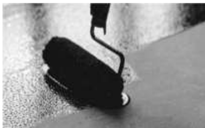
Рис.3 Нанесение обмазочной гидроизоляции
