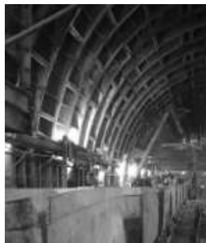
Рис. 1. Тюбинги в метро Шереметьевская, 2018г.
