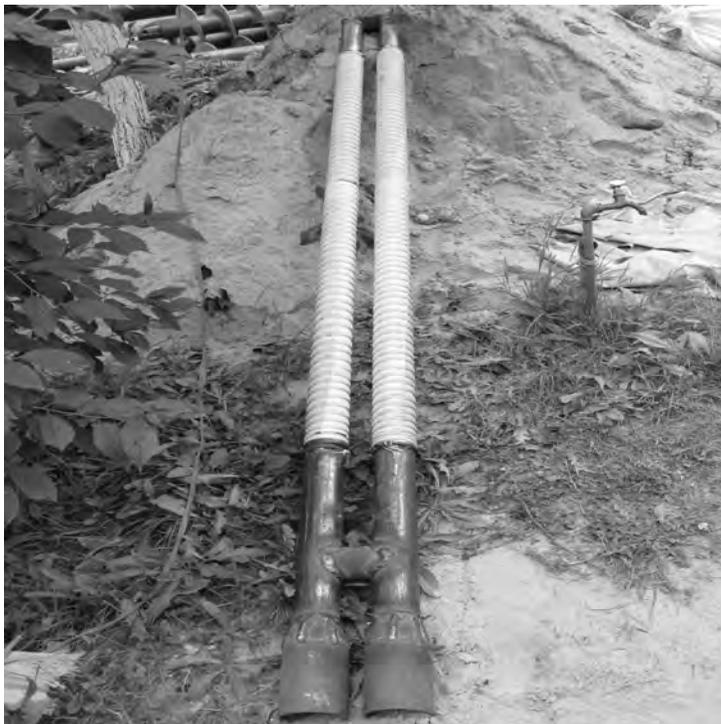
**Рис. 3.** Скважина двухколонной конструкции
