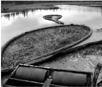
Рис. 5. Сбор нефти с поверхности (Интернет-источник)
