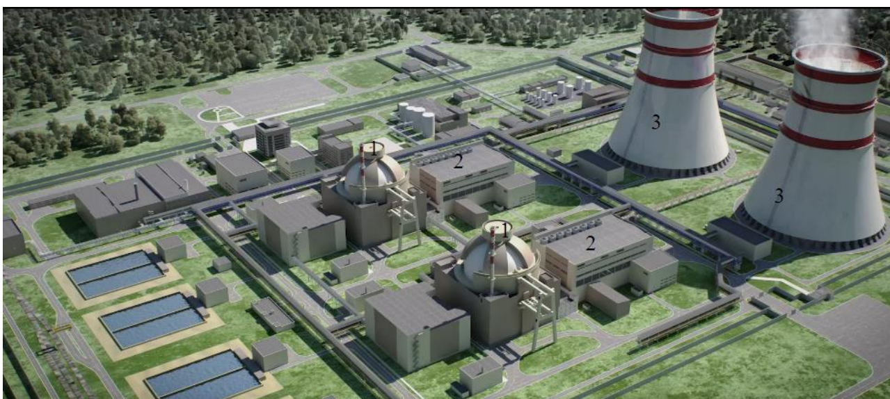
Рис. 3. Комплекс построек атомной электростанции: 1- реакторный зал; 2- турбинный зал; 3- градирня. (фото с сайта www.rosatom.ru )
