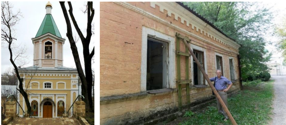
Рис. 5. Здания Спасо-Преображенской церкви: общий вид и деформации
