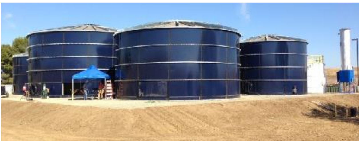
Рис. 3. Органическая масса разлагается под воздействием микроорганизмов в условиях отсутствия (или минимального присутствия) кислорода.
