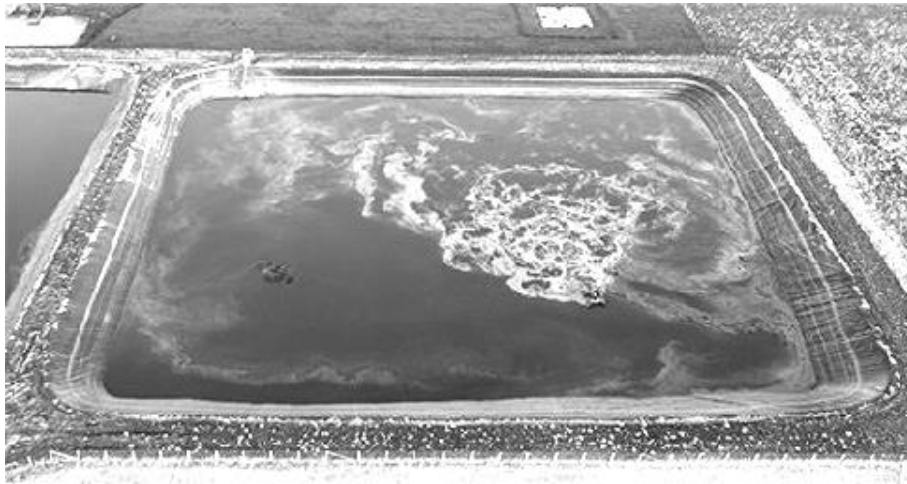
Рис. 1. Сбор и хранение в открытых сооружениях. Поступление кислорода обеспечивается за счет регулярного механического перемешивания вещества.
