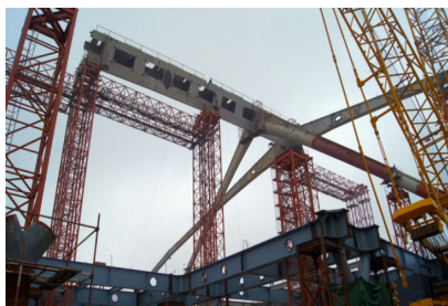
а) устройство временных опор
