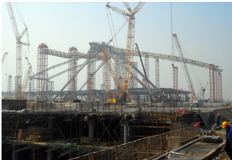
Рис. 6. Полузакрытый способ возведения конструктивных элементов ТПУ
