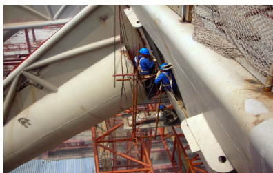
в) закрепление конструкций
