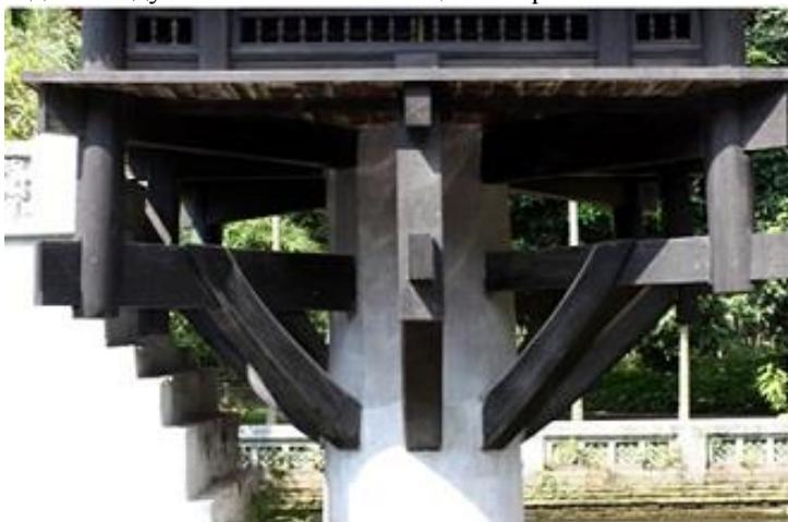
Рис. 2. Самая уникальная архитектура Пагоды- деревянные балки, расположенные на одной колонне
