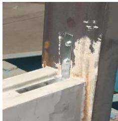
Рис. 3. Узел крепления панели к элементам стен
