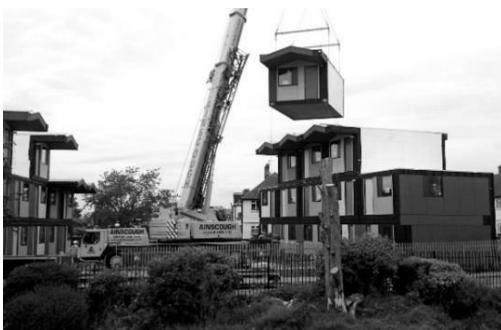
Рис 2. Сборка жилого комплекса Y:Cube
