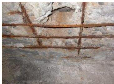
Рис. 1. Коррозия арматуры в бетоне
