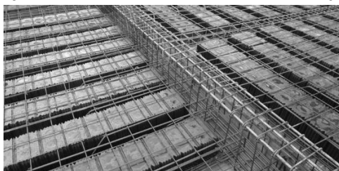
Рис.3 Виды вкладышей-пустообразователей:
