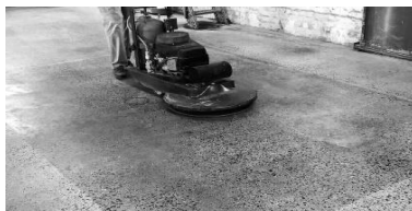
Рис. 1. Восстановление покрытия из декоративного бетона
