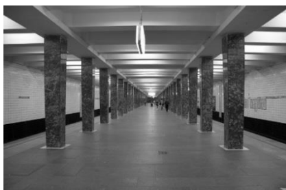
Рис. 3 Трехпролетная станция (Первомайская)
