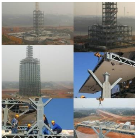
Рис. 1. Монтаж строительного модуля
