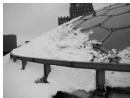
Рис. 4. Характер распределения снега в нижней части купола
