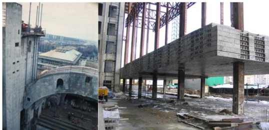
Рис. 3. Подъем различных конструкций при помощи гидравлического домкрата GORILLA NSL
