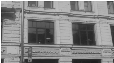
Рис. 3. Пример фасада здания исторической застройки с новыми оконными блоками из ПВХ профиля
