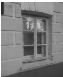
Рис. 4. Пример частичной замены оконного заполнения (с сохранением внешней рамы)
