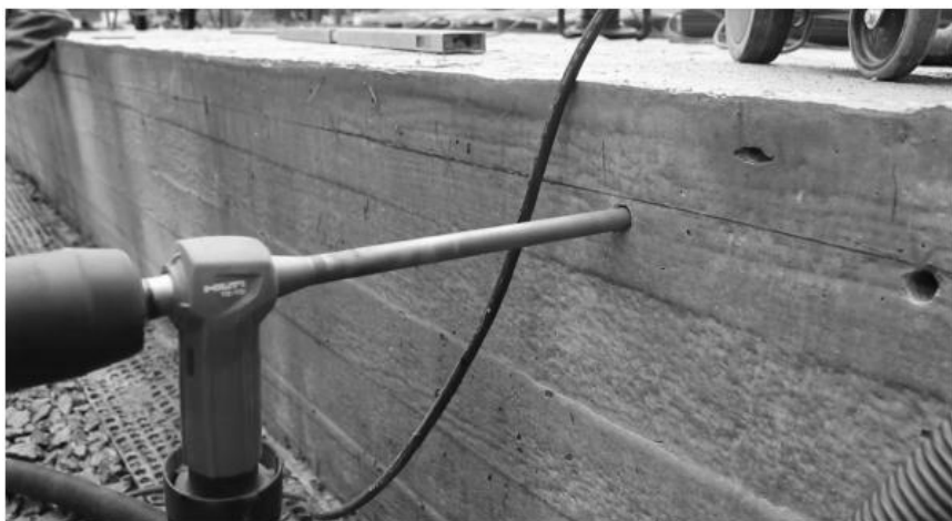
Рис. 1. Общий вид пустотелого бура «Hilti»
