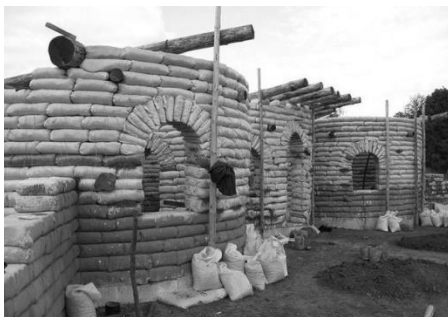
Рис. 2. Землебитный дом из мешков с грунтом.
