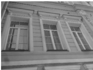
Рис. 5. Пример полной замены оконного заполнения (с использованием оконных блоков)
