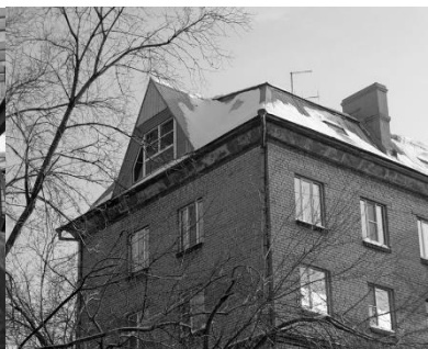
Рис. 3 Кирпичный пятиэтажный дом с надстроенной мансардой.
