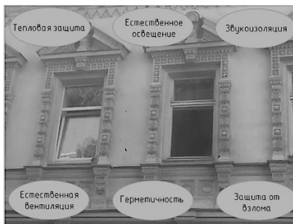
Рис. 1. Современные требования, предъявляемые к конструкциям оконных блоков
