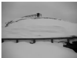
Рис. 2. Равномерное распределения снега сразу после снегопада
