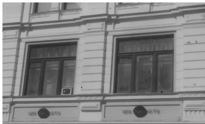
Рис. 2. Пример фасада здания исторической застройки со старым оконным заполнением
