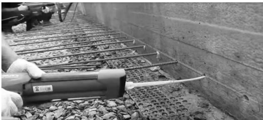
Рис. 2. Химические анкера «Hilti REBAR»
