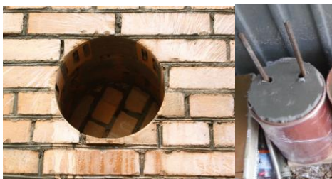
Рис. 1. Отверстие под опорный элемент и опорный элемент
