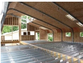
Рис. 1. СИП-панели на металлическом каркасе
