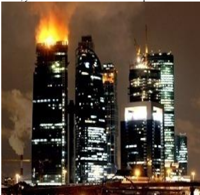
Рис. 1. Пожар на строящейся Восточной башне комплекса «Федерация». Москва – Сити, 2012 год.
