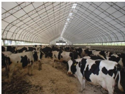
Рис. 3. Каркасно-тентовый ангар для содержания животных: а - вид изнутри, б - вид снаружи
