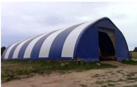
Рис. 3. Каркасно-тентовый ангар для содержания животных: а - вид изнутри, б - вид снаружи
