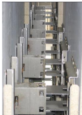
Рис. 1. Ряд замковых соединений в стене
