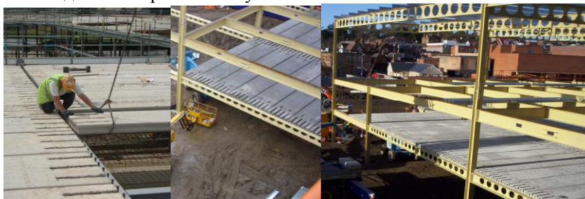
Рис. 1. Сборные пустотные железобетонные плиты
