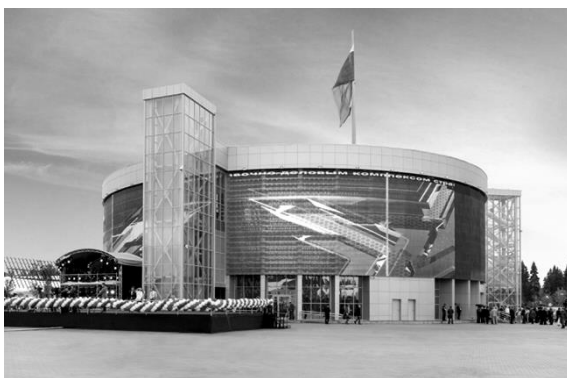
Рис. 1. Здание конгресс-центра в парке «Патриот»
