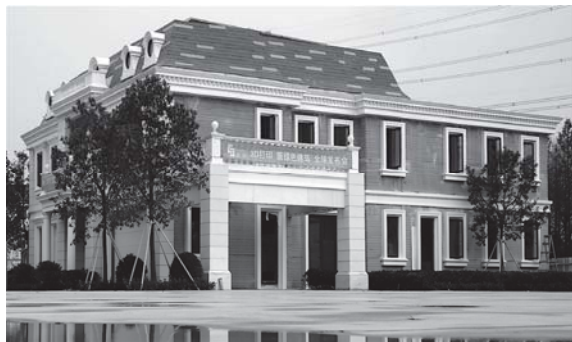
Рис. 3. Жилой дом, распечатанный 3D-принтером. Пекин
