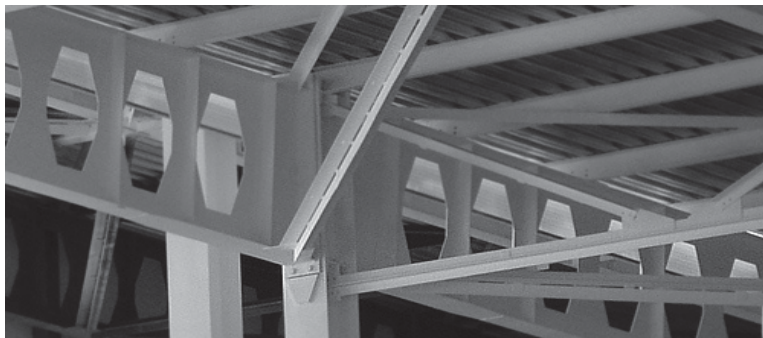
Рис. 2. Несущие конструкции из развитых двутавров
