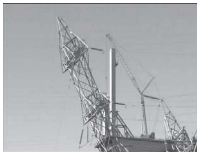
Рис.7. Консольный кран устанавливающий пилоны
