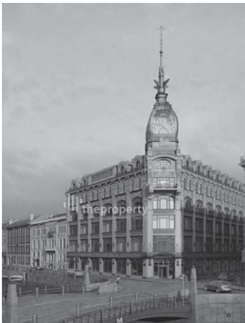
Рис. 5. Многофункциональный комплекс «У Красного моста», Адмиралтейский район, Набережная реки Мойки, д. 73-79
