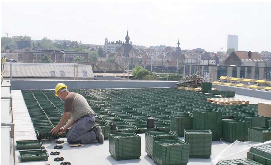
Рис. 1. Устройство зеленых кровель на регулируемых опорах
