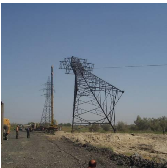
Рис. 4. Повышенная башенная опора №19 в процессе монтажа.
