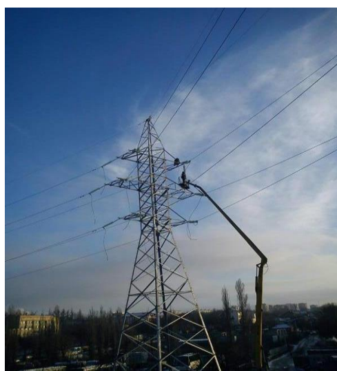
Рис. 5. Монтаж проводов и тросов на повышенной опоре №24.
