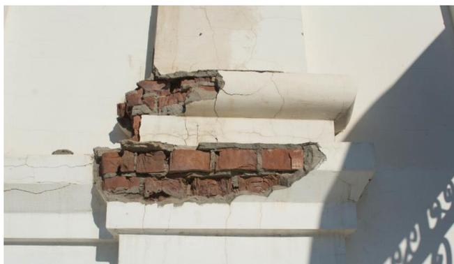
Рис. 2. Поверхность оштукатуренного архитектурного элемента кирпичной кладки, подлежащая ремонту
