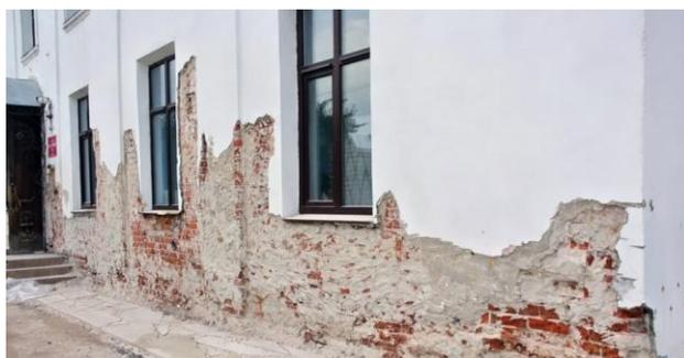
Рис.1. Поверхность плоской кирпичной стены, подлежащая ремонту
