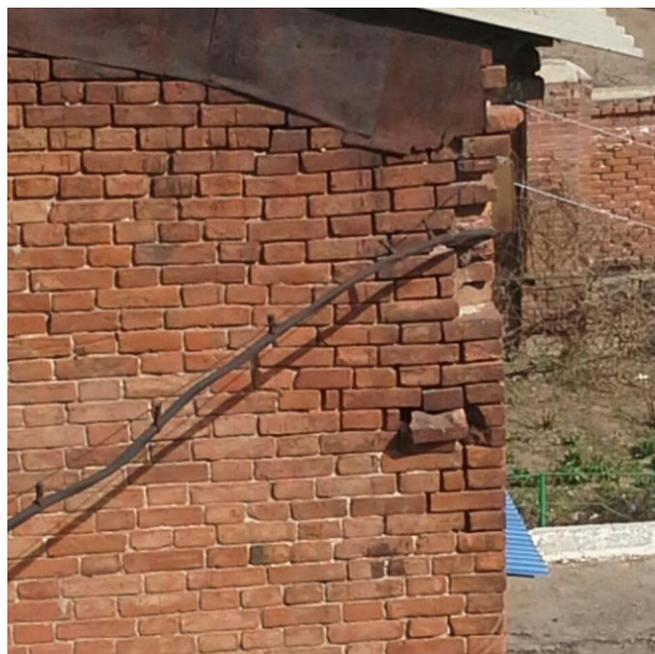
Рис. 4. Характерные признаки выветривания и вымывания раствора из кладки, вываливание кирпичей
