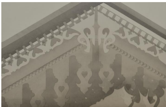
Рис 3. Фрагмент мезонина главного фасада жилого флигеля на ул. Полонского, 13а
