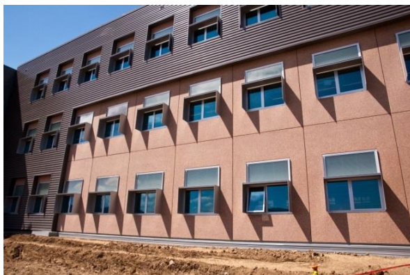
Рис.1. Применение СЗУ на южном фасаде здания
