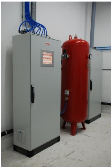
Рис.2. Модуль газового пожаротушения
