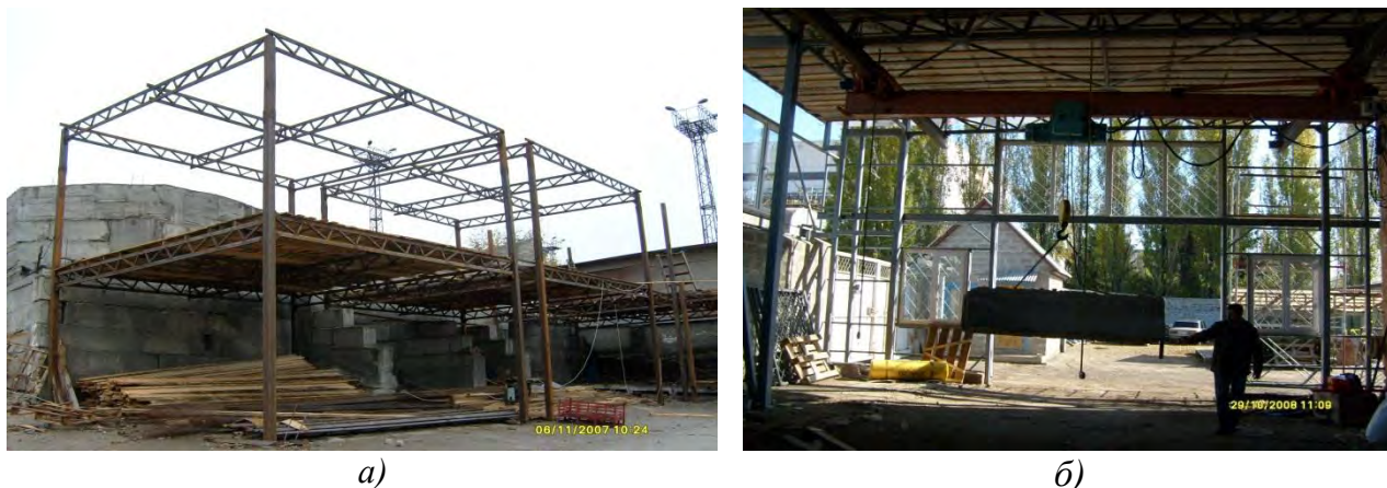
Рис. 1. Снимки модулей складского строения (а) и промышленного здания (б)
