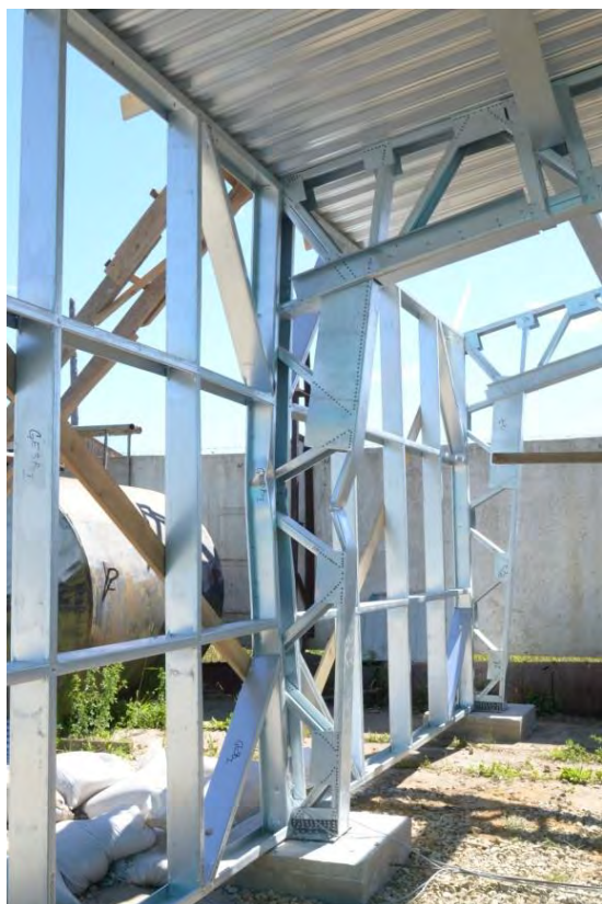
Фото 2. Потеря устойчивости внутренней ветви левой и правой стоек сквозной рамы
