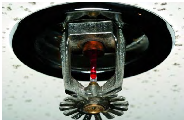
Рис. 2. Спринклерный ороситель
