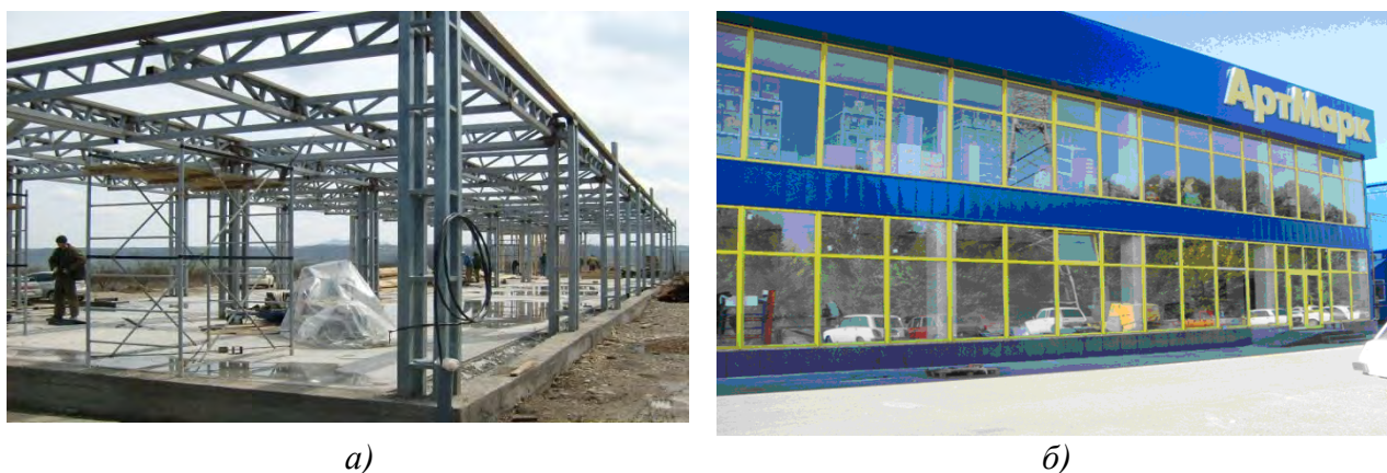
Рис. 5. Снимки здания торгового предприятия с первым этажом из восьми блоков перекрытия размерами в плане 6 \times 6 м, а также с ГВЭ из четырех блоков перекрытия размерами в плане 12 \times 12 м в процессе строительства (а) и эксплуатации (б)
