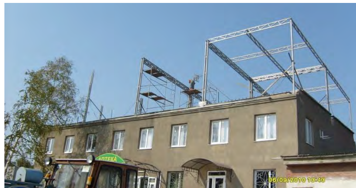
Рис. 4. Снимки реконструкций одноэтажного здания с ГВЭ из четырех блоков покрытия размерами в плане 5×5 м (а) и двухэтажного здания с ГВЭ из восьми блоков покрытия размерами в плане 6×6 м (б)
