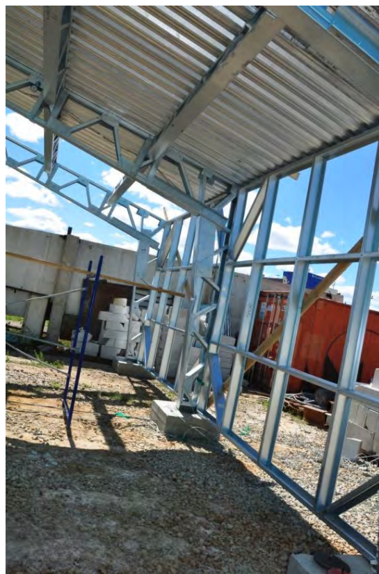
Фото 2. Потеря устойчивости внутренней ветви левой и правой стоек сквозной рамы
