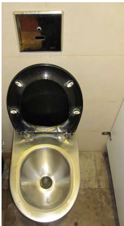
Рис. 3. Унитаз с системой бесконтактного смыва
