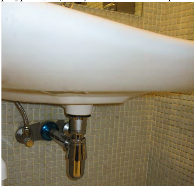
Рис. 2. Сифон (гидрозатвор) пол умывальником
