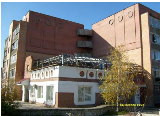
Рис. 4. Снимки реконструкций одноэтажного здания с ГВЭ из четырех блоков покрытия размерами в плане 5×5 м (а) и двухэтажного здания с ГВЭ из восьми блоков покрытия размерами в плане 6×6 м (б)
