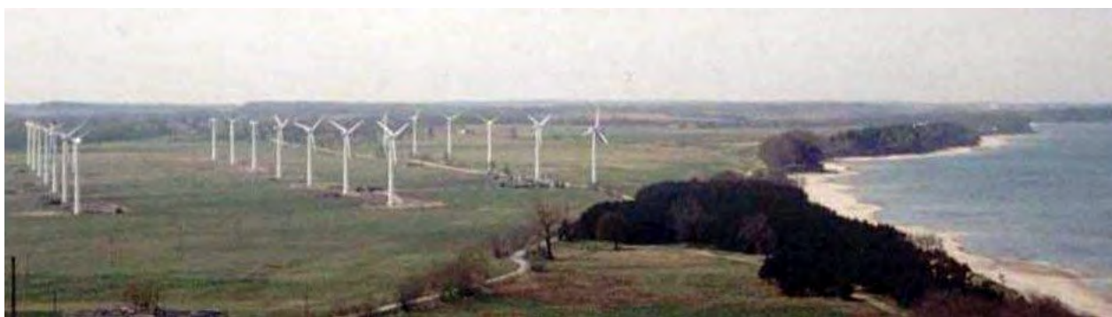
Рис. 1. Панорама ветропарка мощностью 5.1 МВт (21ВЭУ – 225Vestas и 1ВЭУ – 600 Wind-World) в Калининградской области
