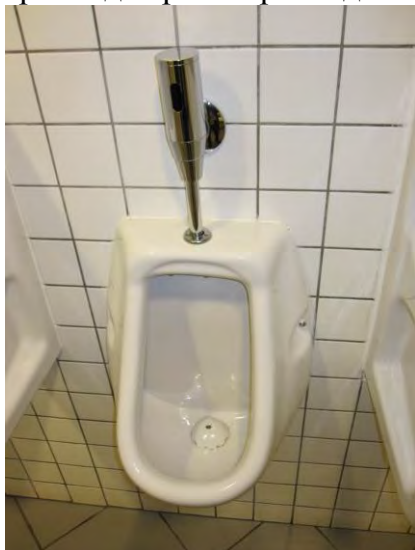
Рис. 4. Писсуар с системой бесконтактного смыва
